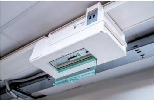
La distribution d'énergie décentralisée des chargeurs VE avec le système de distribution électrique Canalis est la solution optimisée pour les parkings et garages couverts. Les kits de distribution EVlink dotés d'une boîte de sortie préassemblée permettent une connexion directe à la canalisation électrique, ce qui réduit le temps et les coûts d'installation. Les extensions sont réalisées rapidement et en toute sécurité.
